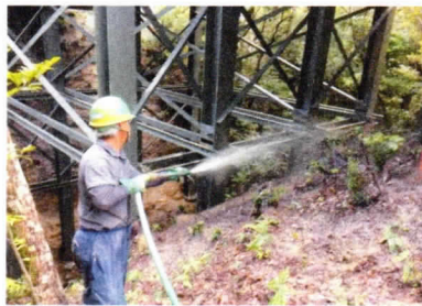
開発工事で用いている例
