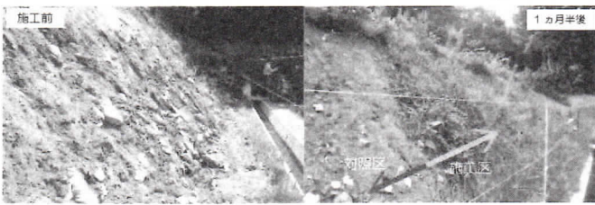
施工後の状況(農地造成法面への適用例：北海道)
