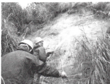
施工状況(崩壊斜面への適用例：沖縄県)
